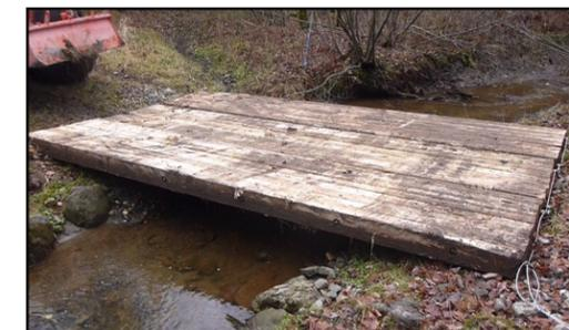
Un billot peut être déposé à chaque extrémité de la traverse afin de la protéger lors du débardage.
