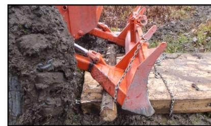
Pour l'installation, un billot d'une longueur de 6' sert d'appui afin que le tablier puisse être élevé au-dessus du cours d'eau.
